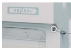
Selagem do acesso ao interior do quadro
