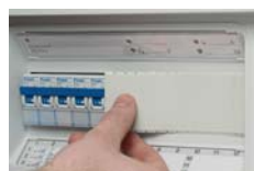
Máscaras para cobertura de módulos não utilizados
