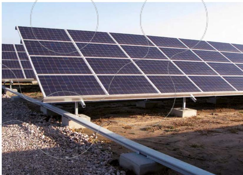
O sistema de caminhos de cabos isolantes Unex é desenhado tendo em conta a absorção de dilatações. A distância “**d**” entre os troços dos caminhos de cabos e das tampas, varia em função da diferença entre a temperatura máxima e a temperatura de instalação.
