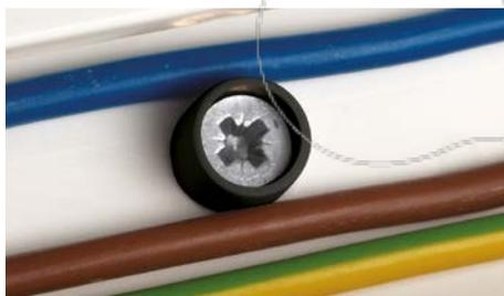
Instalação protegida contra contactos elétricos. O taco protege a cabeça do parafuso.
