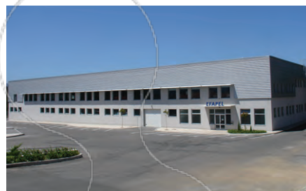
Unidade Produtiva de Serpins - Edifício 2
