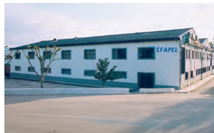
Unidade Produtiva de Serpins - Edifício 1
