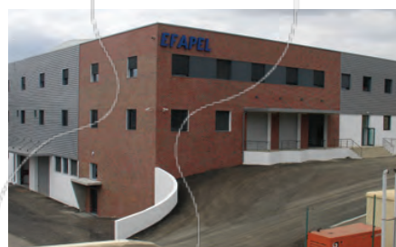
Unidade Produtiva de Serpins - Edifício 3
