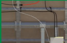
**2** Instalação BT DC entre painéis e caixas de ligação (string combiner box)
