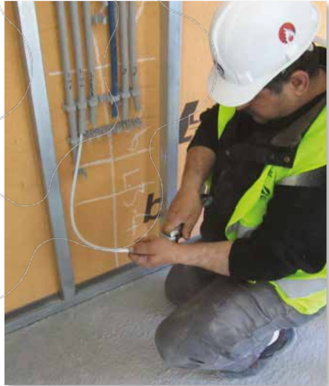
Kablo montajında kılıfın kolay sıyırılması, zaman kazandırır.
