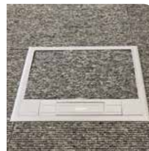
Corte do revestimento em esquadria
