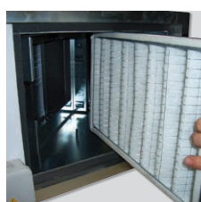
AFR Substituição do filtro.
