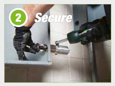
**Secure SPEED LOCK onto draw stud:**
