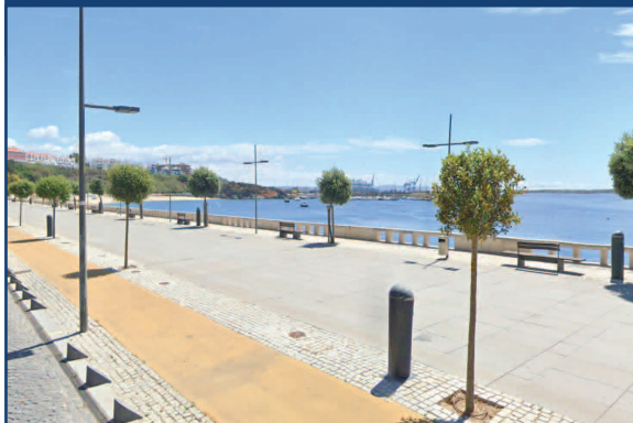
20 Colunas de distribuição instaladas na Av. Vasco da Gama, Sines
