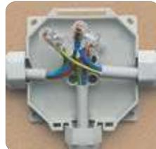
Graças ao seu desenho inovador, diferentemente do que ocorre para uma caixa standard, não é preciso romper as paredes para introduzir o cabo.
